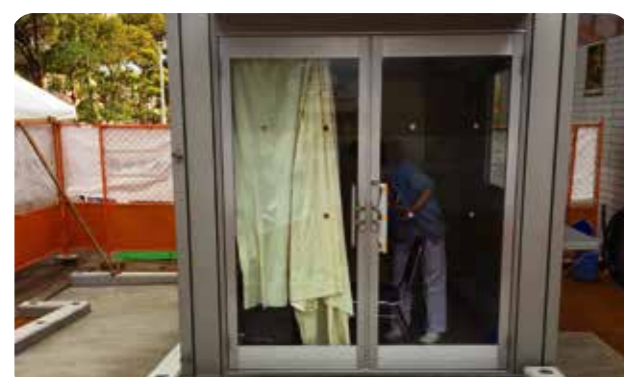
検査棟 出入口
